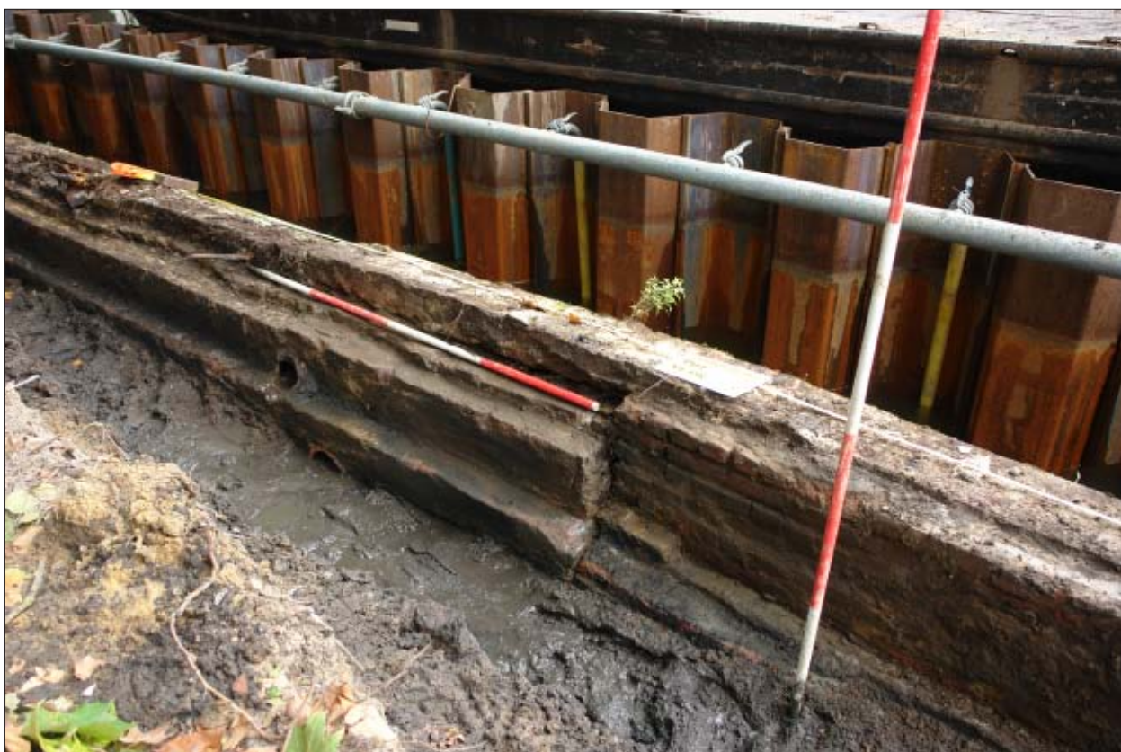
Afb. 5.10 Een overgang in het metselwerk van de gesloopte lage walmuur.
