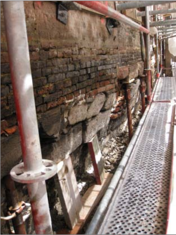
Afb. 4.6 Overzicht van de kluismuur van huis De Ster met zicht op een stuk van het metselwerk van Doornikse steen met daarboven negentiende- en twintigste-eeuwse baksteenmetselwerk (opname: H. Hundertmark 2011).
