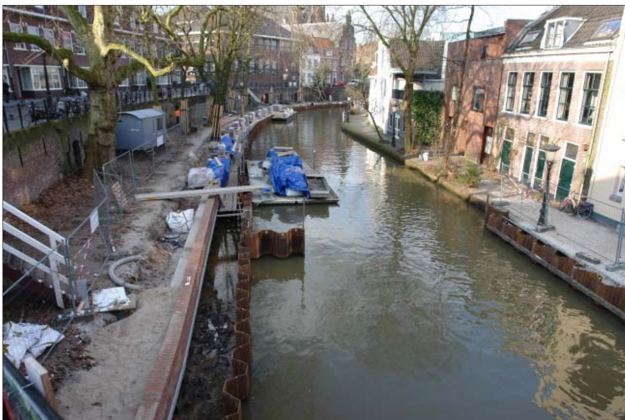
Afb. 3.2 De renovatiewerkzaamheden in volle gang op 13 februari 2013, gezien vanaf de Bijlhouwersbrug. Op de voorgrond is het eerste deel van de nieuwe lage walmuur zichtbaar.
