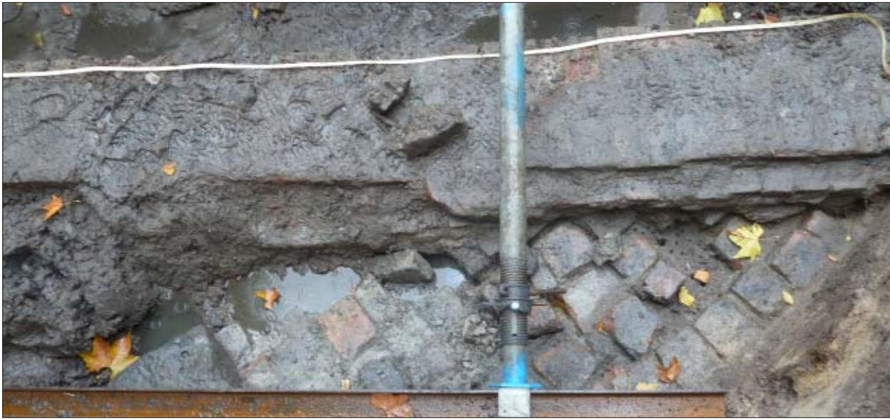
Afb. 5.4 De dertiende-eeuwse fundering van de werfmuur op vlak 1. De fundering ligt gedeeltelijk nog onder de lage walmuur.
