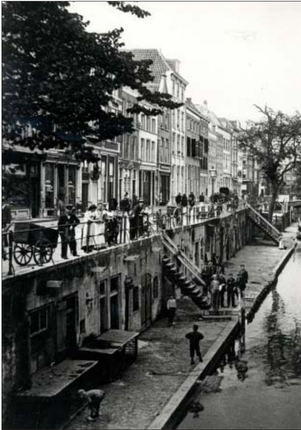
Afb. 2.5 De Oudegracht omstreeks 1900. Op sommige plaatsen was de kade inmiddels van baksteen, maar er waren ook nog delen met een houten beschoeiing. Op de nog particuliere werven stonden ook hokken voor konijnen of kippen, zo blijkt uit deze foto (links onderaan) (bron: Het Utrechts Archief).
