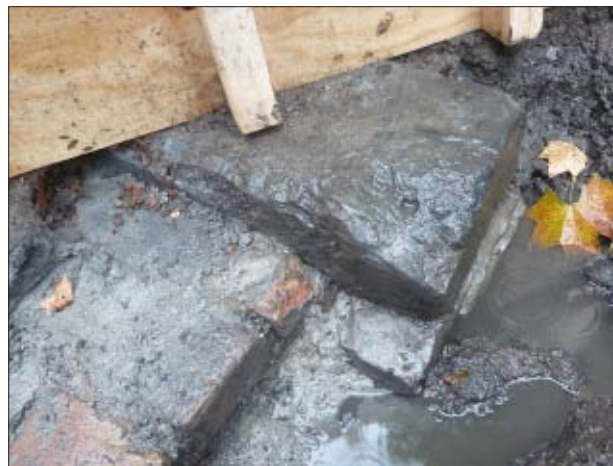
Afb. 5.6 De dertiende-eeuwse fundering was aan de buitenzijde bekleed met grote blokken natuursteen.
