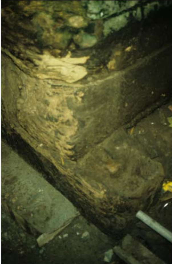
Afb. 4.2 Uitstekend blok met draaipunt voor een (sluis)deur in de noordwesthoek van het zestiende-eeuwse bruggedeelte (foto: H. Hundertmark) (zie afb. 2.8 en 4.1 voor de locatie van dit draaipunt).
