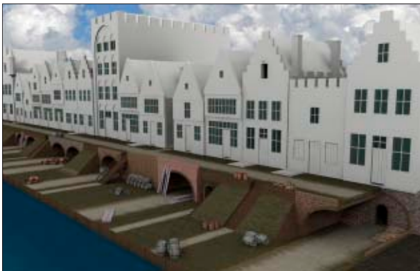
Afb. 2.2c Tunnels en werfkelders (1200-1300)
