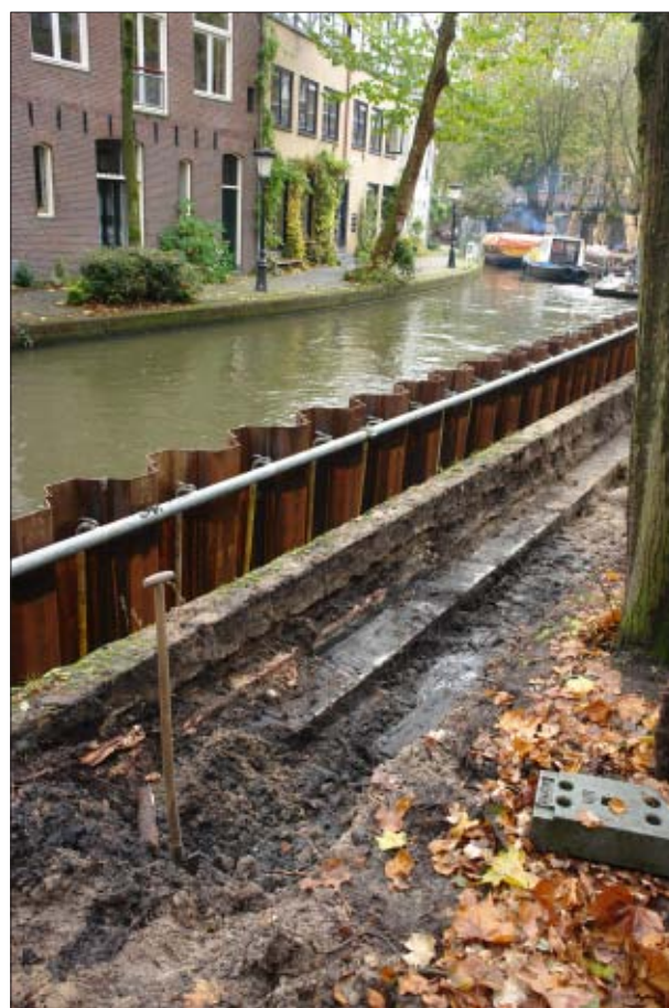
Afb. 3.3 De werksituatie tijdens de archeologische begeleiding. In de Oudegracht is een tijdelijke damwand geplaatst. Achter de lage walmuur is een ca. 1,5 m brede zone met ca. 70 cm verdiept. Op de achtergrond is nog net zichtbaar hoe de grond met behulp van containers op een duwboot wordt afgevoerd.
